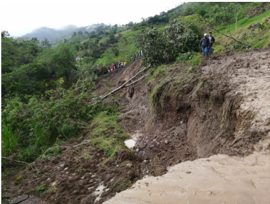
IMAGEN 1. DERRUMBE DE LADERA EN SAN ANTONIO, COPÁN
