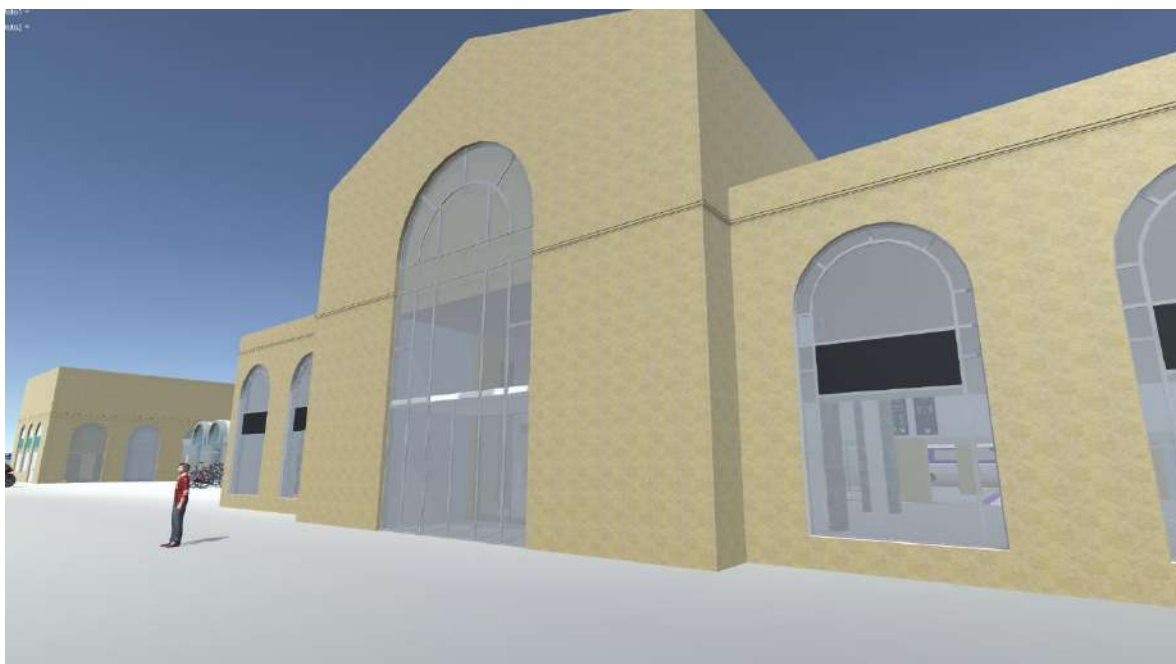
Figura 26 Frontis de la estación
